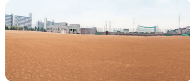
グラウンド改良工事
