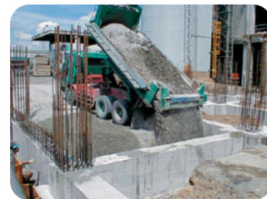
建設工事の埋戻し
