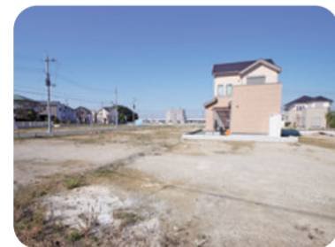
軟弱土壌改良工事
