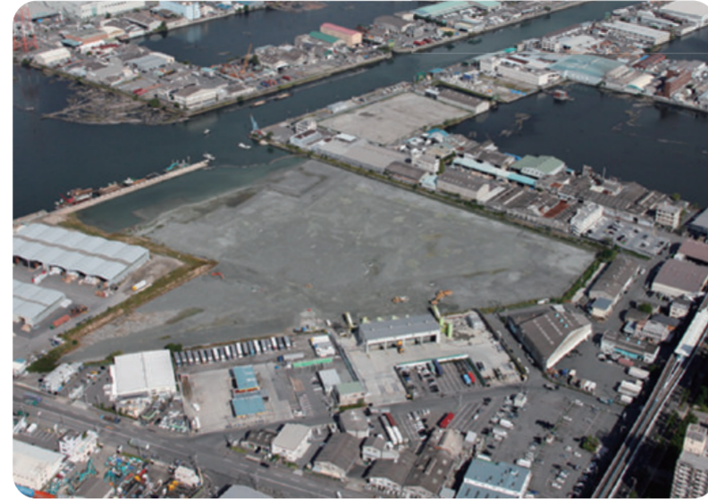
大和川線シールド発生土再生活用事業(大阪市第6貯木場の埋立)
