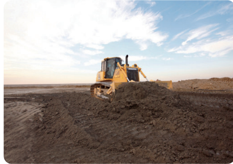
大阪湾広域臨海環境整備センター(フェニックス埋立処分場の覆土)
